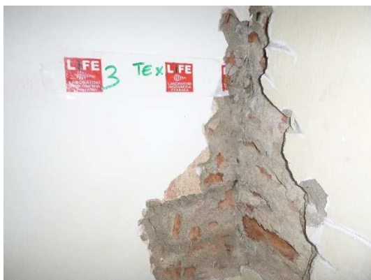
Figura 3: rimozione degli intonaci per la valutazione del grado di ammorsamento del nodo ID3.
