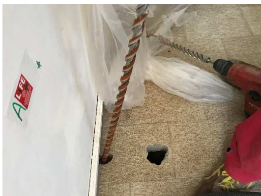
Figura 10: operazioni di perforazione del nodo tra solaio di piano terra e parete perimetrale.
