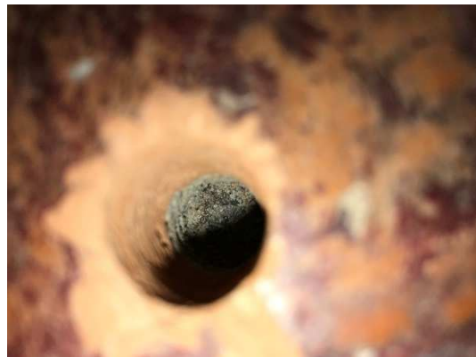
Figura 4: saggio estradossale per la valutazione dei carichi portati dal solaio.
