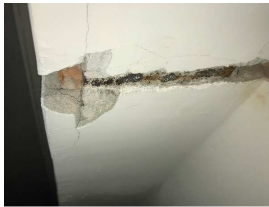
Figura 6: traccia intradossale sull'architrave, onde metterne in luce uno dei due profili metallici che la compongono.
