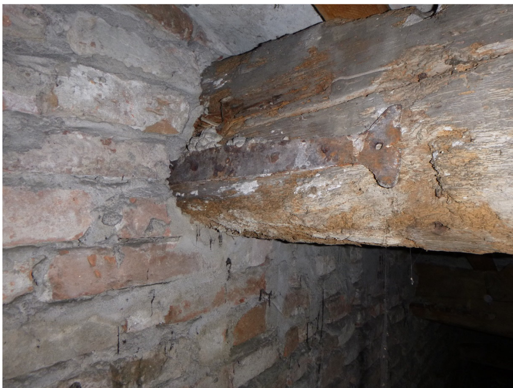
Figura 5: degrado superficiale da xilofagi
