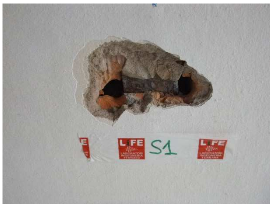
Figura 5: messa in luce del singolo travetto metallico, per il solaio di piano primo ID S1.
