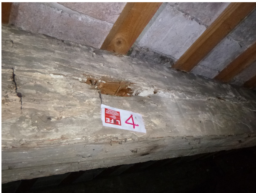
Figura 6: fessurazione ampia su trave n.4
