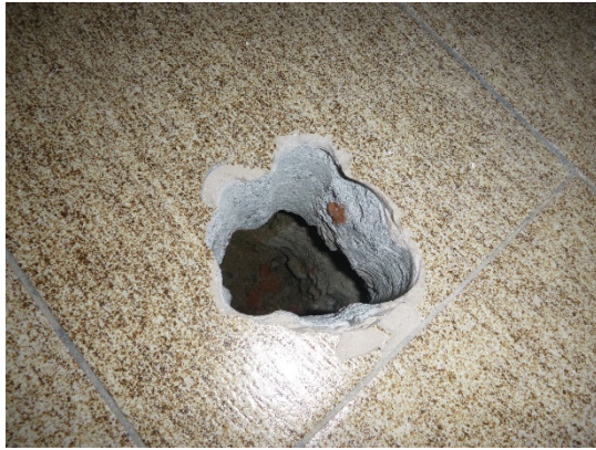
Figura 7: saggio estradossale per la valutazione dei carichi portati dal solaio ID S2.
