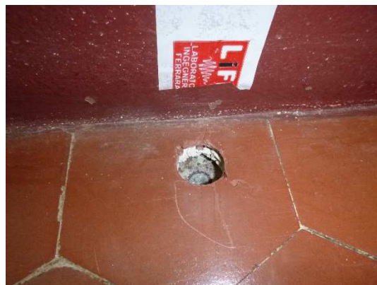
Figura 6: saggio estradossale per la valutazione dei carichi portati dal solaio ID S1.
