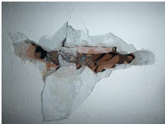
Figura 3: messa in luce del singolo travetto metallico.
