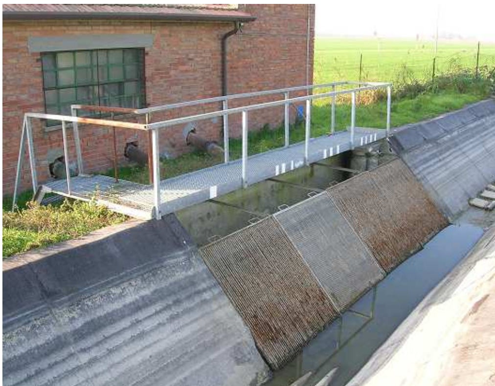
Figura 8. Stazione di pompaggio ed opera di presa laterale.
