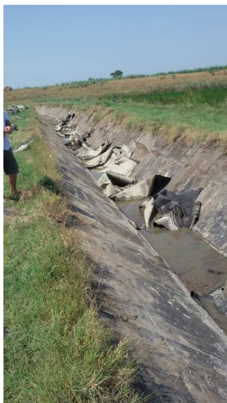
Figura 11. Situazione di degrado degli adduttori.
