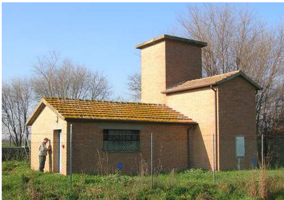
Figura 9. Fabbricato con stazione di pompaggio e torretta di alloggiamento per la fornitura di energia elettrica.
