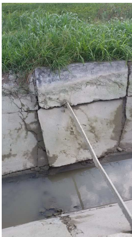
Figura 11. Situazione di degrado degli adduttori.
