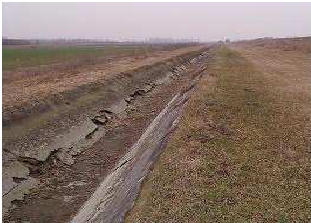
Figura 10. Stato di conservazione del primo tratto di un adduttore.
