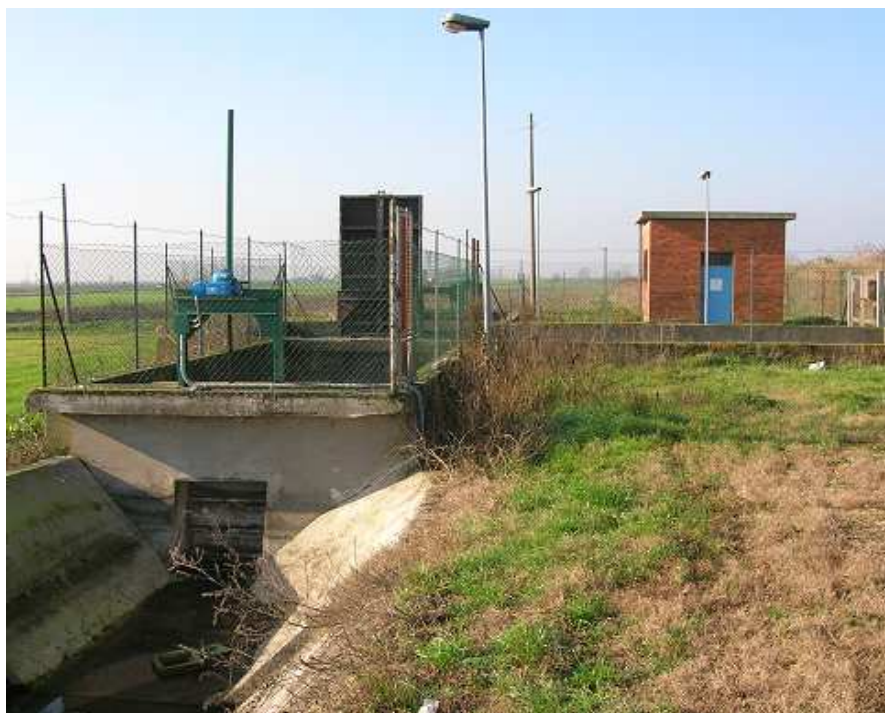
Figura 6. Vasca di calma posta all'origine dei due Addottori Pega Est ed Ovest.
