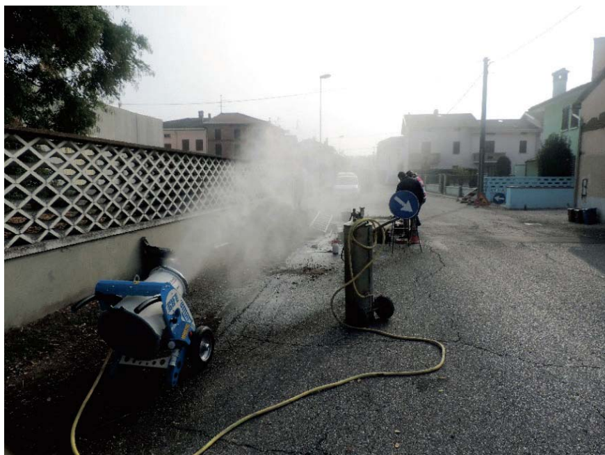
Figura 5 - Cannone nebulizzatore nell'area d'intervento.
