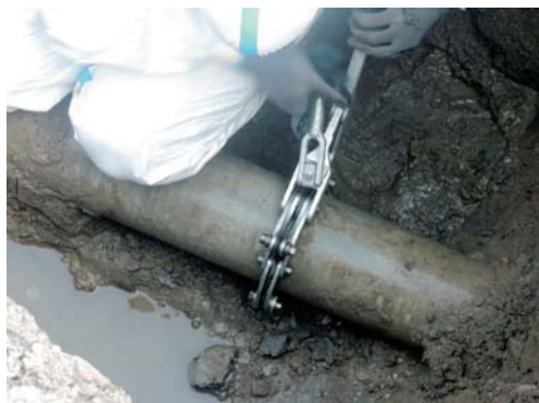
Figura 8 - Taglio di una tubazione mediante tagliatubi manuale a catena.
