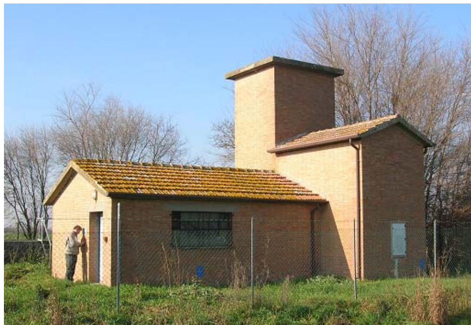
Fig. 5 Fabbricato con stazione di pompaggio e torretta di alloggiamento per la fornitura di energia elettrica.
