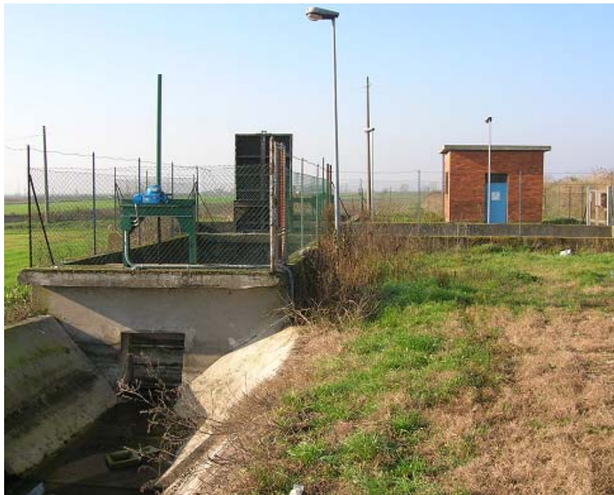
Fig. 2 Vasca di calma posta all'origine dei due Addottori Pega Est ed Ovest.
