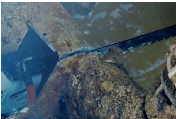
Figura 7 - Taglio di una tubazione mediante seghetto alternativo a motore (a scoppio) a bassa velocità di rotazione.
