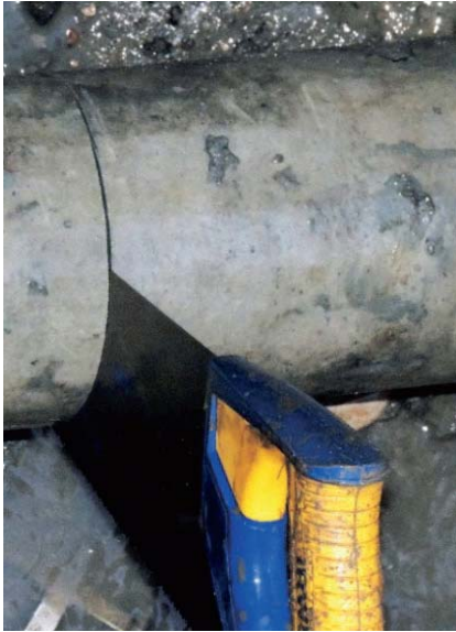
Figura 6 - Taglio di una tubazione mediante seghetto manuale (Inail Dit).
