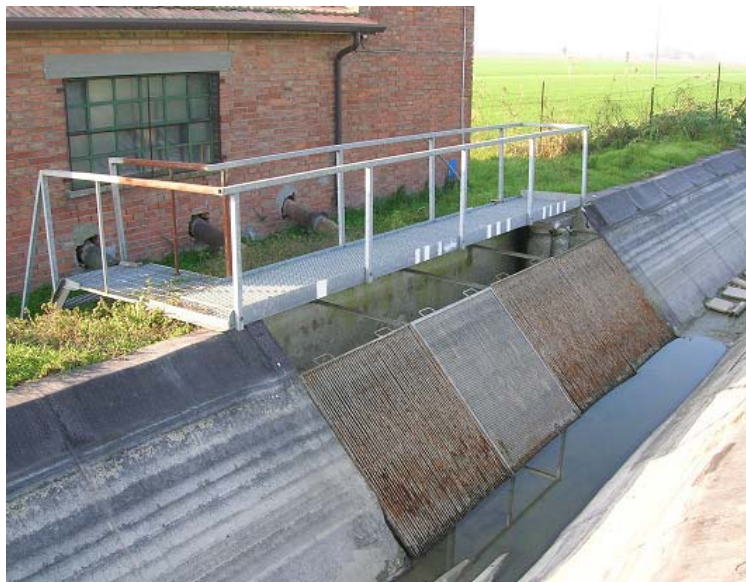
Fig. 4 Stazione di pompaggio ed opera di presa laterale.
