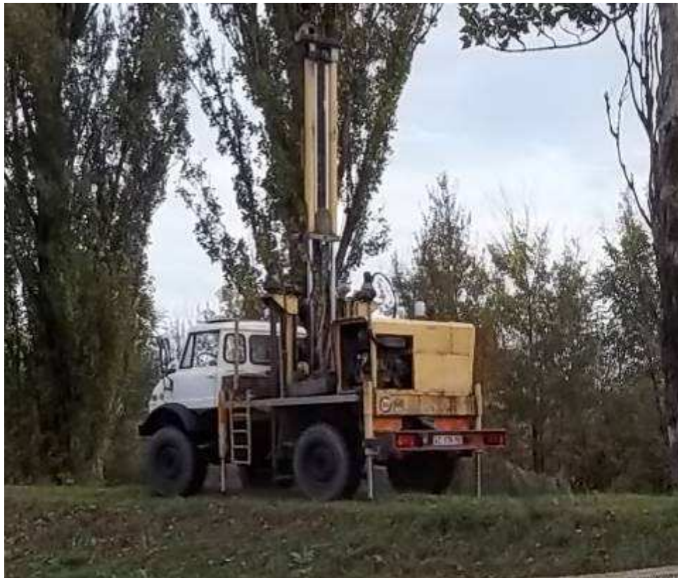
Penetrometro da 20 ton montato su Unimog-Mercedes
