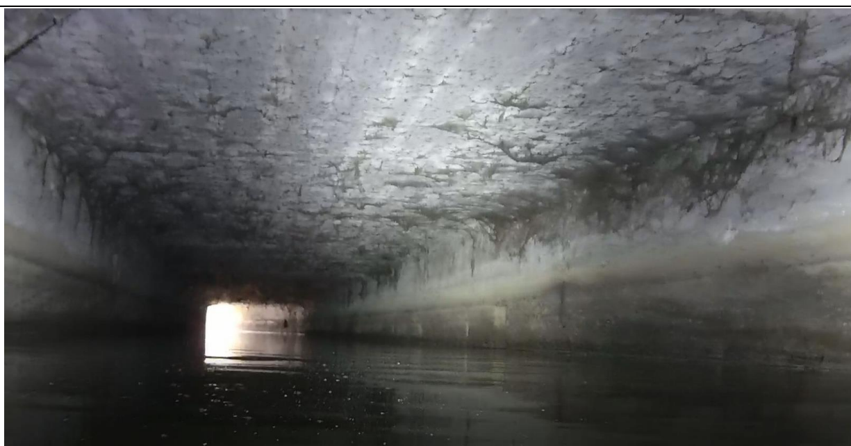
Figura 8: Dettaglio scatolare in c.a - stato di conservazione
