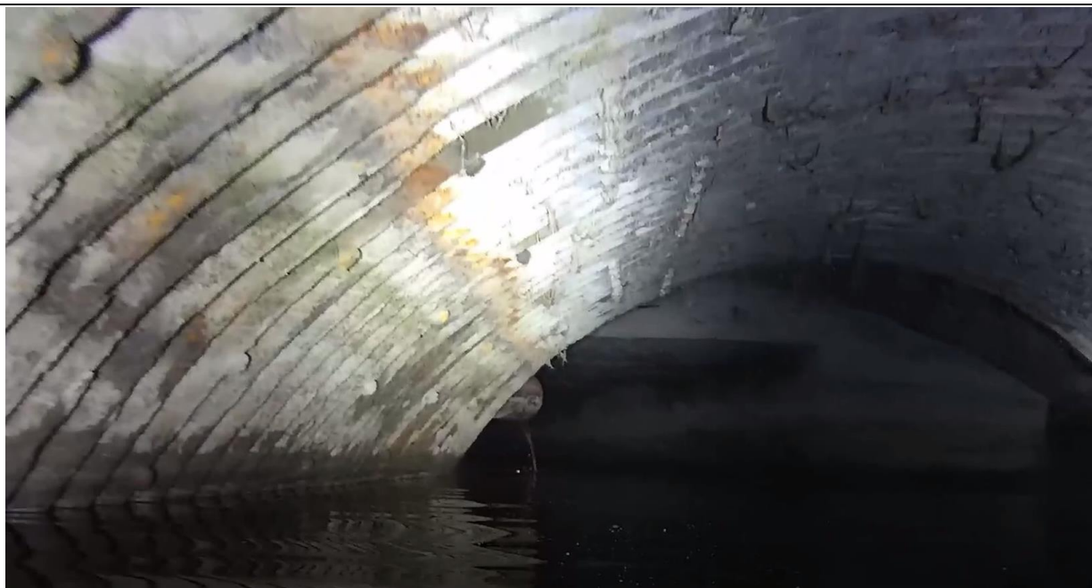
Figura 7: Dettaglio tubo finsider esistente - stato di conservazione e punto di collegamento con scatolare in c.a.
