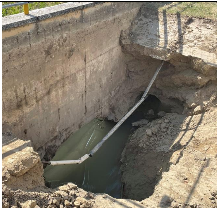
Figura 11: Zona dove si è verificato il crollo del tubo
