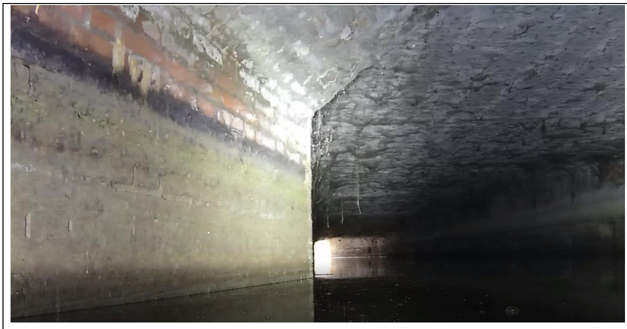
Figura 9: Dettaglio manufatto di raccordo in muratura tra tubo finsider e scatolare – vista 1
