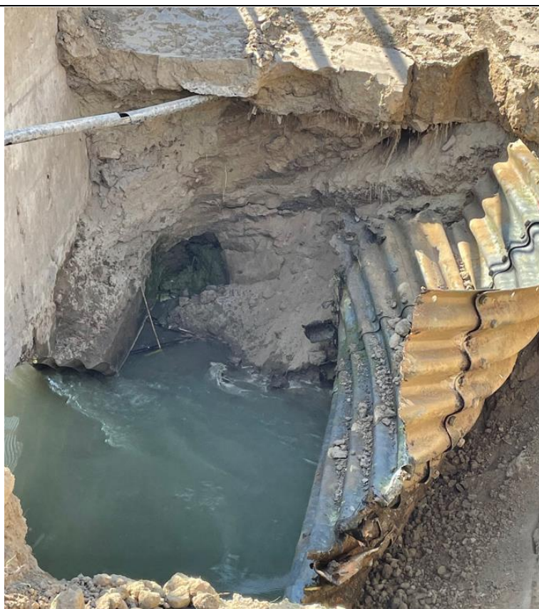
Figura 12: Dettaglio lamiera tubo esistente danneggiata
